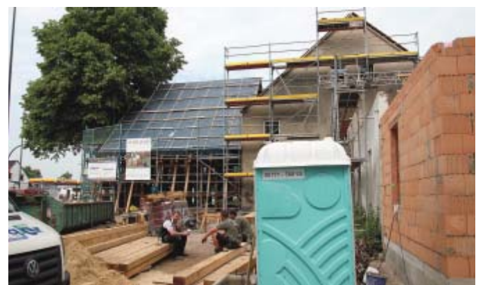
Viel zu tun: Die beiden Bestandsgebäude und rechts der neue Anbau für Sanitäreinlagen.
