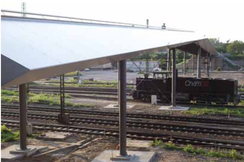
11 Bahnverkehr unter der Brücke © Krebs+Kiefer Ingenieure GmbH
