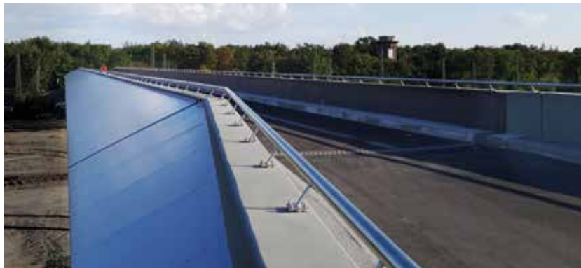
10 Blick nach Süden in den Oberwald © Krebs+Kiefer Ingenieure GmbH
