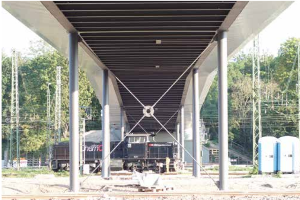
15 Untersicht mit Queraussteifung © Krebs+Kiefer Ingenieure GmbH
