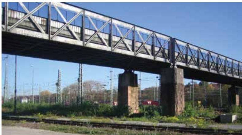
2 Historisches Bestandsbauwerk von 1895 © Krebs+Kiefer Ingenieure GmbH
