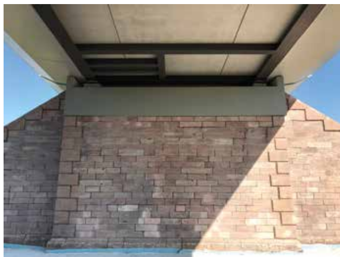
16 Integration des Bestandswiderlagers © Krebs+Kiefer Ingenieure GmbH
