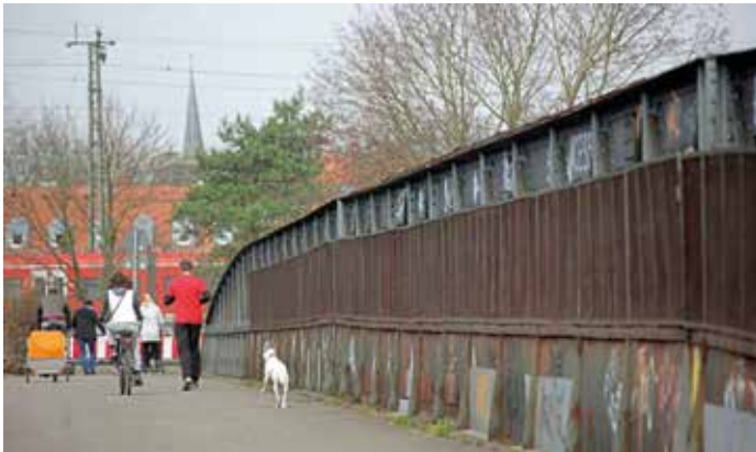
1 Tunnelartige Wahrnehmung im Bestand © GJL Freie Architekten BDA
