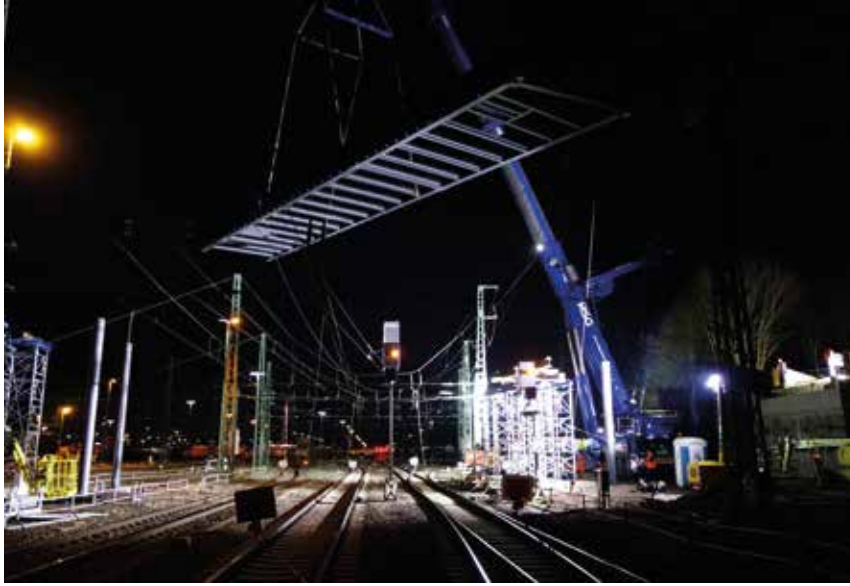
18 Einheben des Überbaus in einer Sperrpause © Krebs+Kiefer Ingenieure GmbH
