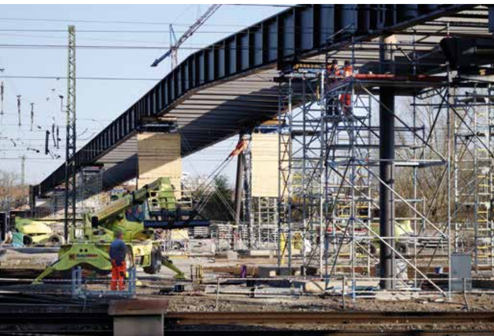
14 Haupttragwerk: Stahlträgerrost auf Montagstützen © Krebs+Kiefer Ingenieure GmbH
