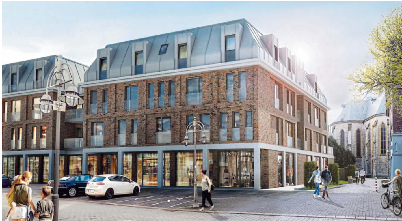
Ansicht von der Kökerstraße aus: Der viergeschossige Doppelkomplex fällt durch eine gegliederte Architektur auf; die unteren Stockwerke sind verklindert, das oberste, zurückgesetzte Geschoss wird von einem Aluminiumband umzogen.
