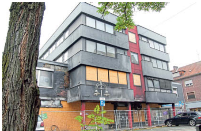
Per Bauzaun gesichert: Das Gebäude an der Kökerstraße brannte im Sommer 2020 aus. Seither steht es leer. Foto: Ludger Osterkamp
