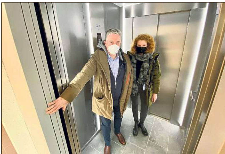
Herzstück der Barrierefreiheit ist der neue Aufzug, den Andreas Grube und Viola Lieneweg vom Büro GJL präsentieren.
