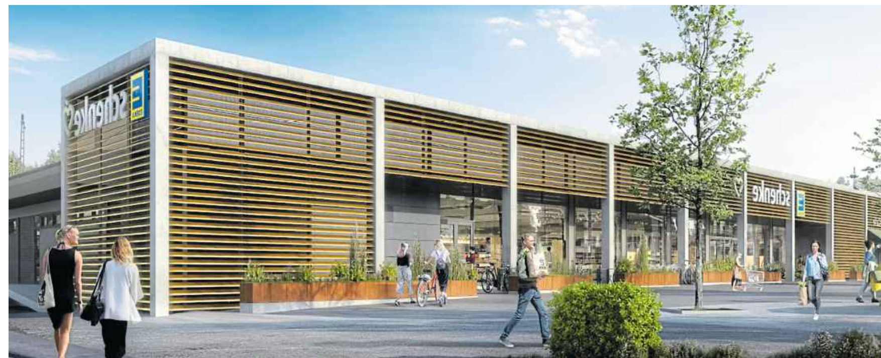
Reizvoll gestaltet: Ein 6,50 Meter hoher Vorbau erstreckt sich lamellenartig längs der Front. Im Inneren betreten die Kunden eine großzügige Mall. Foto: Hauer Partner Architekten
