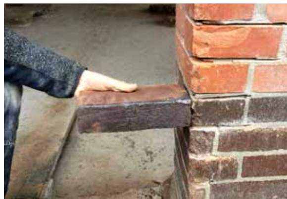
Der Sockel besteht aus dunklen Ziegelsteinen
