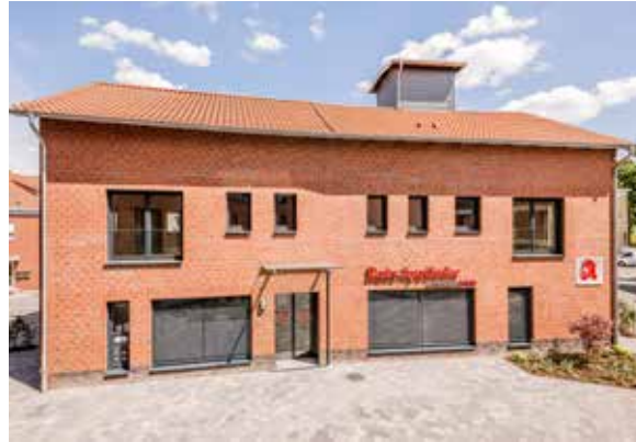
Die Westfassade der ehemaligen Brennerei wurde mit Recycling-Ziegeln ergänzt Foto: Kai Ostermann
